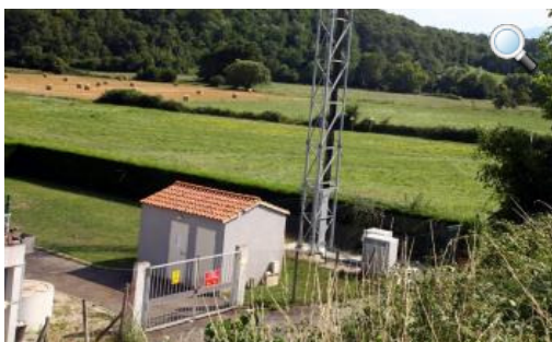
C'est sur le terrain adjacent à la station que se sont installées les caravanes. /Photo DDM, Jal
